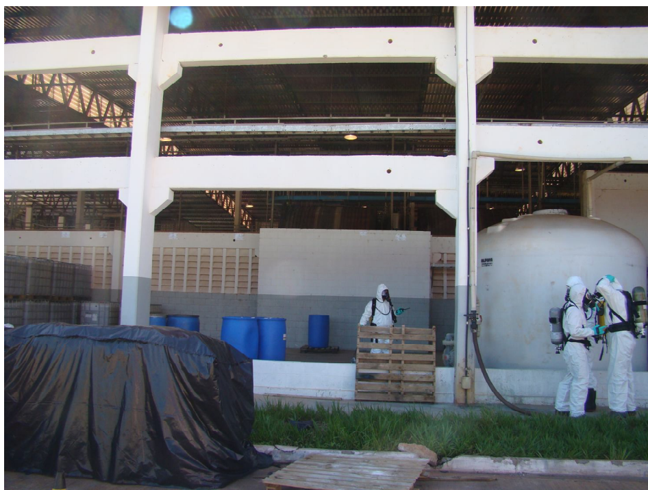
Figura 7. Visão frontal do local onde a mistura acidental ocorreu. Observe que o muro ao fundo (cinza e branco) não alcança a cobertura, formando um vão livre que permitiu a passagem do gás sulfídrico.
