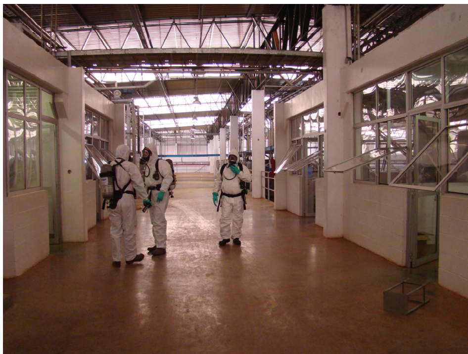
Figura 9. Piso superior da planta fabril. Entradas das salas do setor administrativo no primeiro plano e por onde os trabalhadores saíram (os que conseguiram) após perceberem que estava acontecendo algo muito grave. Um detalhe que chama atenção é a abertura das janelas que obstruiu parcialmente o corredor de circulação, dificultando uma eventual evacuação emergencial
