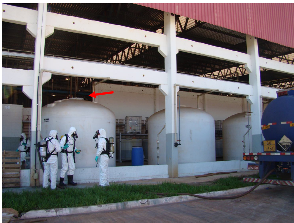
Figura 12. Visão dos tanques da traseira do caminhão envolvido no acidente. Atrás a planta industrial. Seta indica os respiros. Observe que em nenhum tanque há identificação do produto armazenado na face voltada para o ponto de acoplamento.
